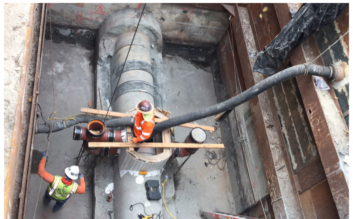
Հյուսիսային Կոյուղու ելքայի անցքերի վերանորոգում
