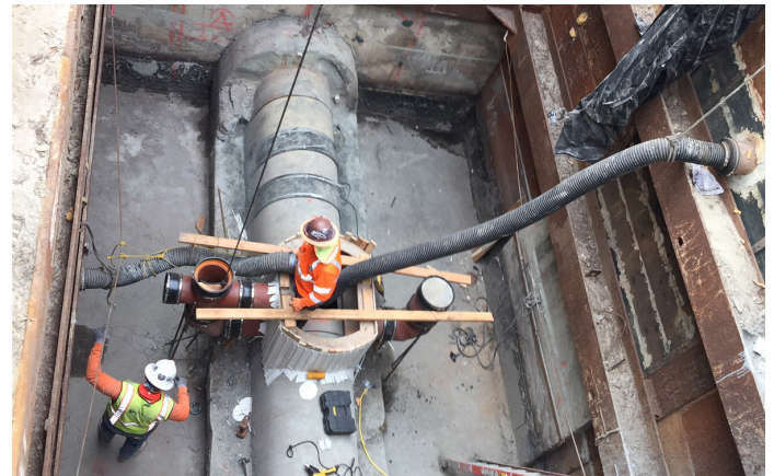
Công Trình Tu Bổ Đường Cống North Outfall
