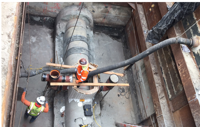
North Outfall 하수구 복구
