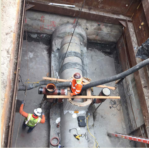
北側排水口污水管道修復工程
