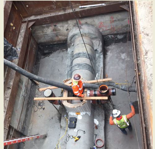
بازسازی خروجی فاضلاب شمال
