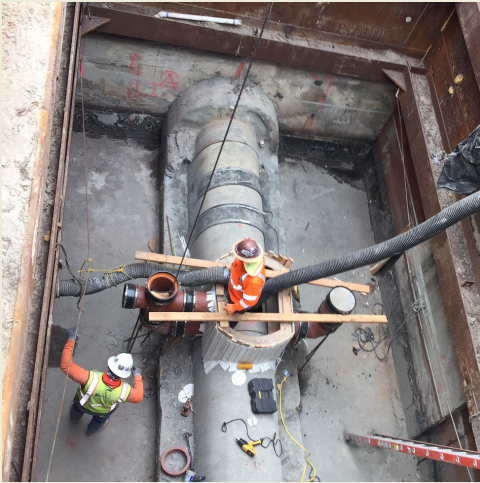
Восстановление Северного выпускного канализационного коллектора
