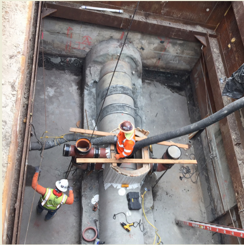
北侧污水排放口管道修复工程
