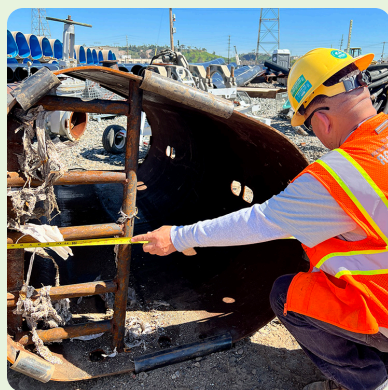
پروژه احیای North Outfall Sewer
